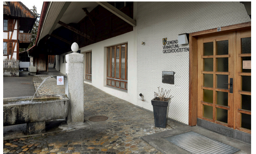
Zu klein: Im Gemeindehaus wird es für die Verwaltung langsam eng. Ein Ausbau oder eine Umnutzung des Gebäudes wird nun geprüft.
